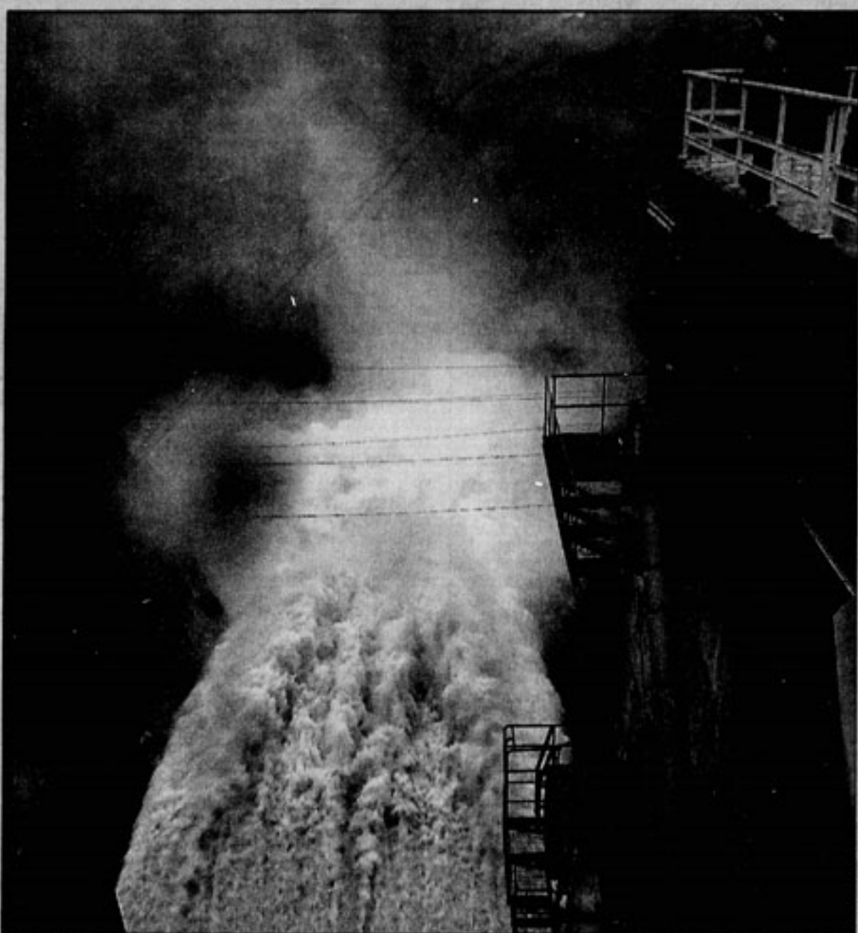
EVACUAN AGUA DESDE EMBALSE DE CENTRAL PANGUE. — La regulación en el embalse de la Central Hidroeléctrica Pangue —con la apertura parcial de las compuertas— permitió mitigar el golpe de agua que recibió tras la crecida originada por la caída del muro de contención en las obras de la central Ralco. El gerente general de Endesa, Héctor López, no descartó un eventual retraso en la puesta en marcha de esta generadora hidroeléctrica. Desde la parte superior de la presa se observa una impresionante caída de agua al curso del río Biobío. (C 1)
